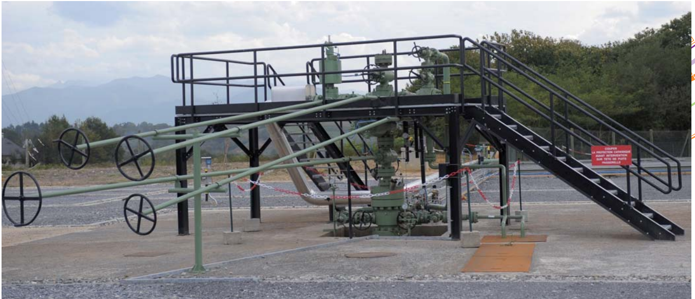
Tête de puits utilisée pour l'injection de CO 2 : le pilote de Total permet de tester dans le bassin de Lacq un projet intégré de captage et de stockage géologique du CO 2 .
