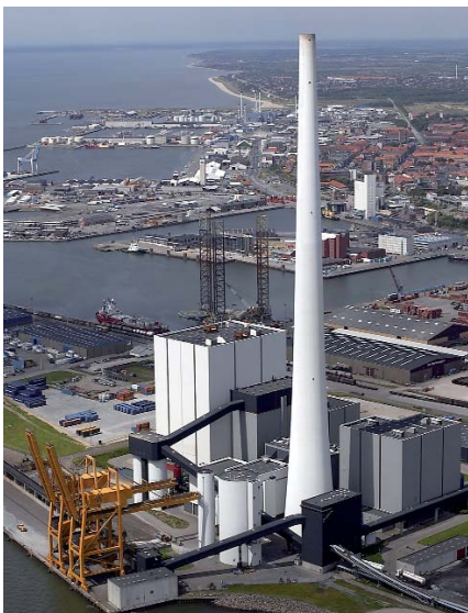
Le pilote industriel installé en 2006 dans le cadre du projet Castor sur la centrale de Dong Energy à Esbjerg (Danemark) est une première mondiale.
