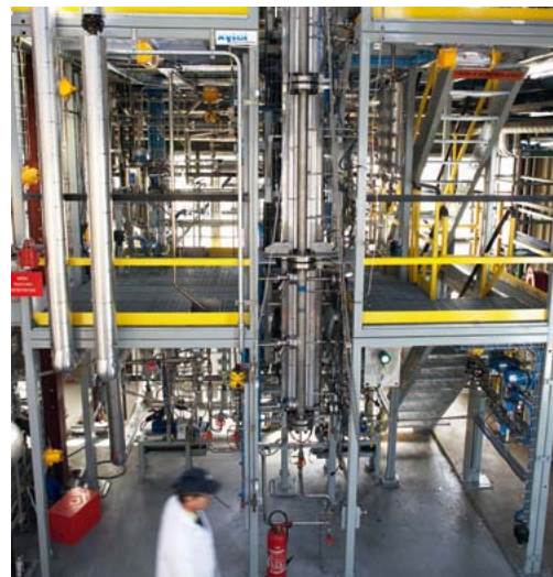
IFP Energies nouvelles permet aux PME partenaires d'accéder à ses moyens techniques d'essais.
