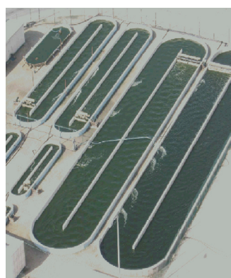
Fig. 4 - Exemples de réacteurs de cultures ouvert et fermé pour la culture de micro-algues
