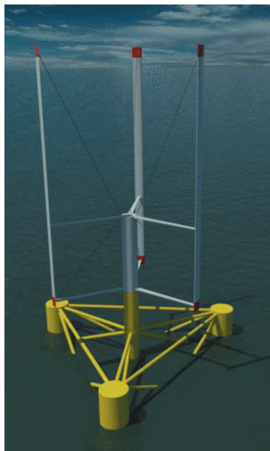
Fig. 4 – L'éolienne flottante Vertiwind
