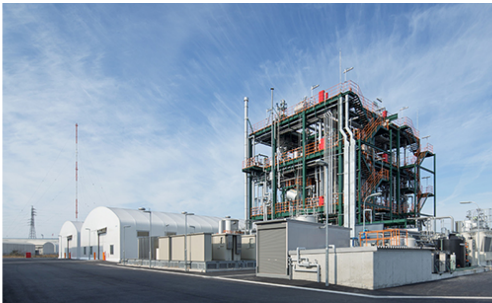
KHP (Kitakyushu Hibikinada Plant), unité industrielle de 22 000 t/an
