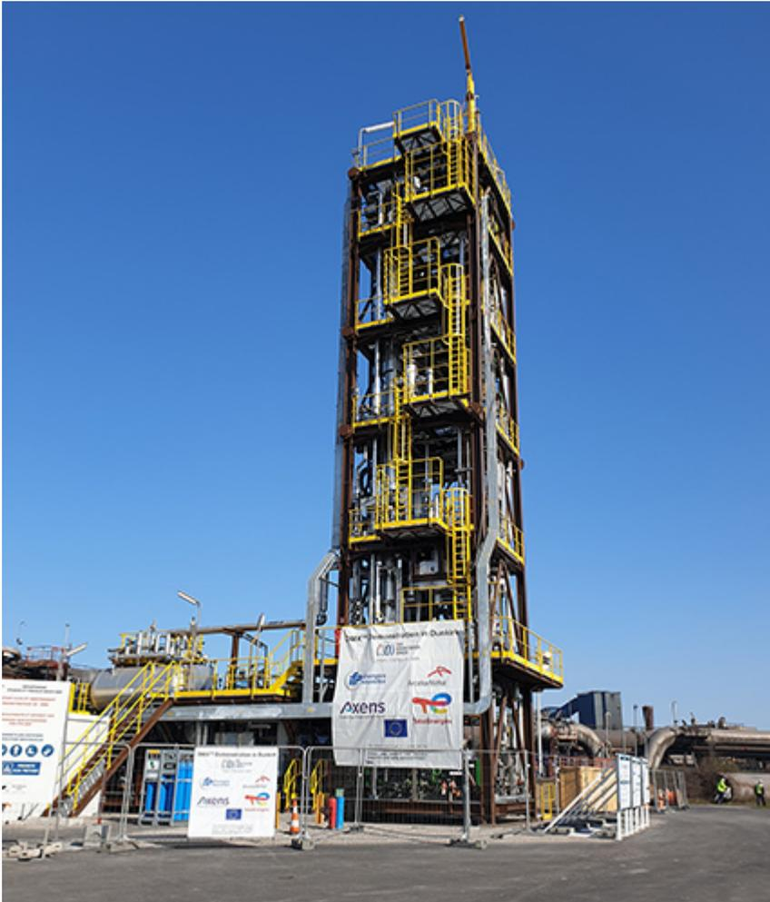
Photo 1 : Démonstrateur industriel DMX(TM) sur le site sidérurgique d'ArcelorMittal à Dunkerque.
