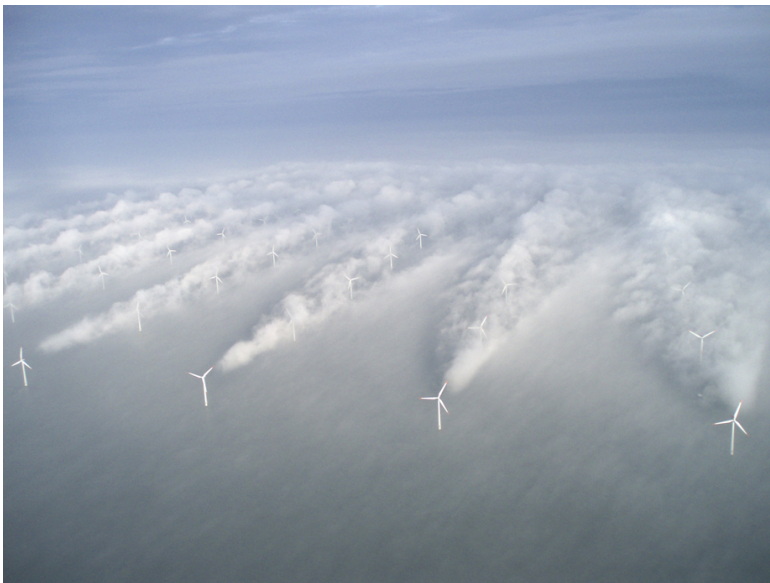
Figure 1. Des effets de sillage visibles sur le parc éolien en mer Horns Rev 1 - copyright Vattenfall.
